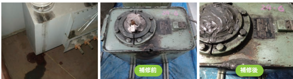
漏洩廃電気機器の例
